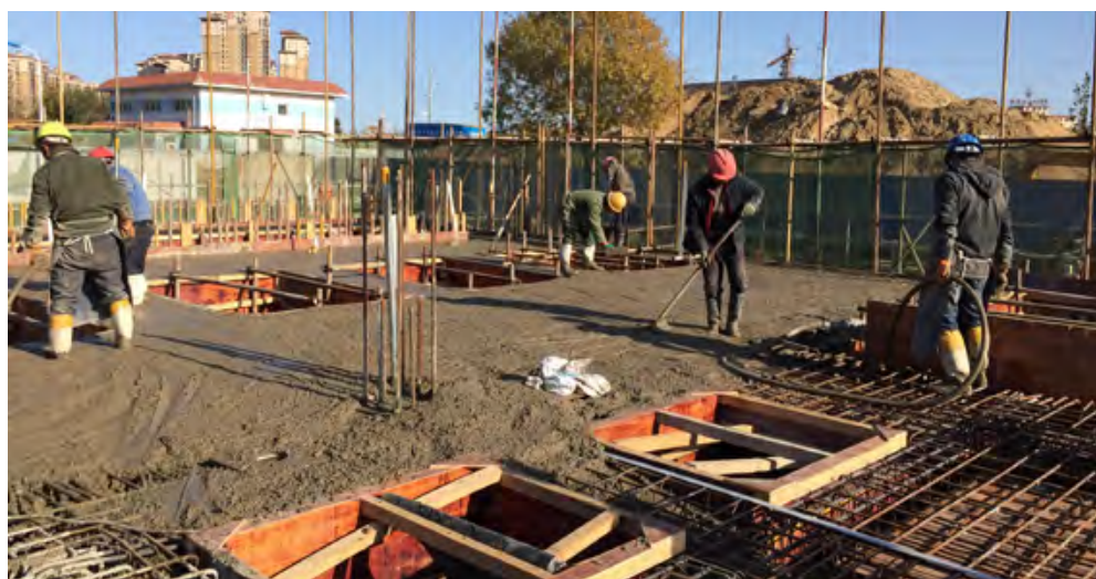
升级改造高效沉淀池
