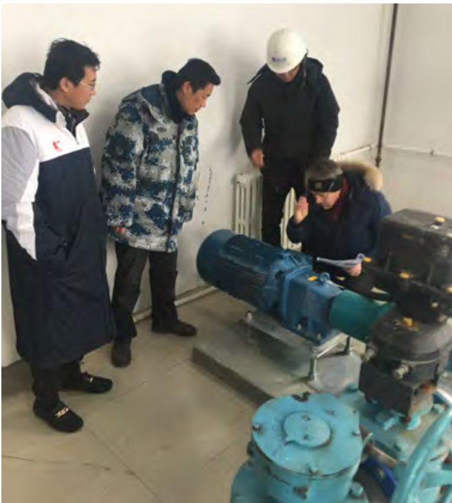
中德专家对安装完成的设备进行核对检查
