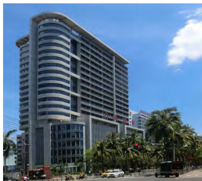
扩建的新医院外观图
