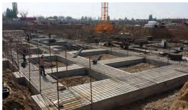
热源厂条形基础制作
