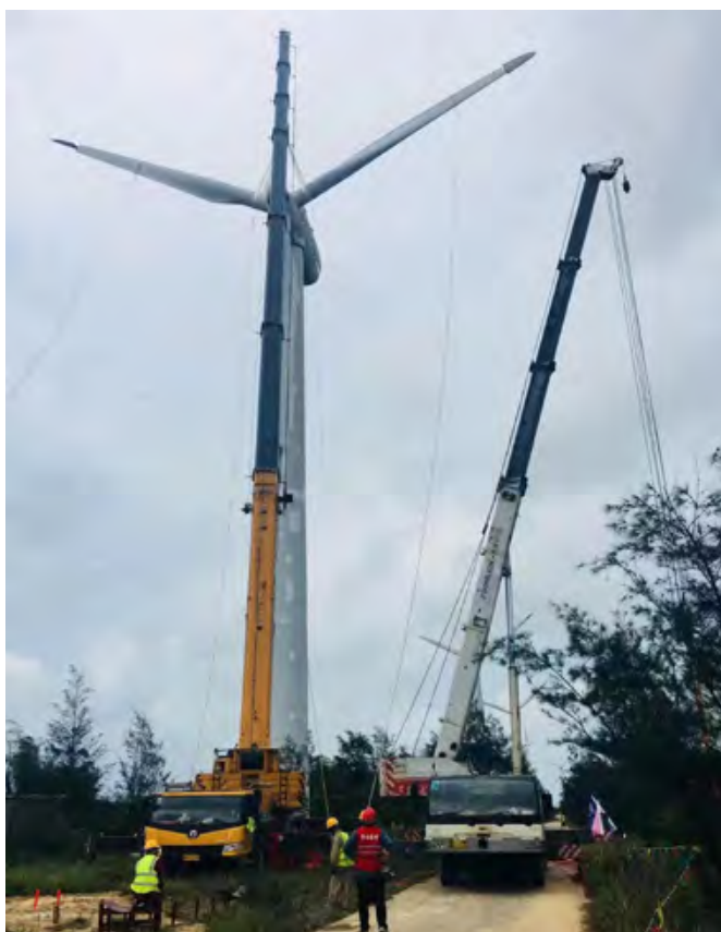
德国NORDEX N43/MK3风机安装过程
