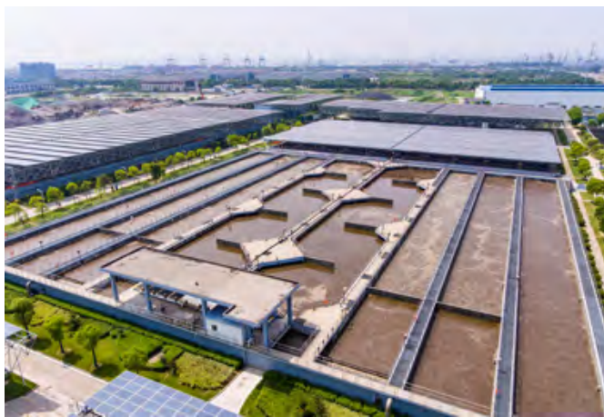
污水处理厂二期工程项目俯视图
