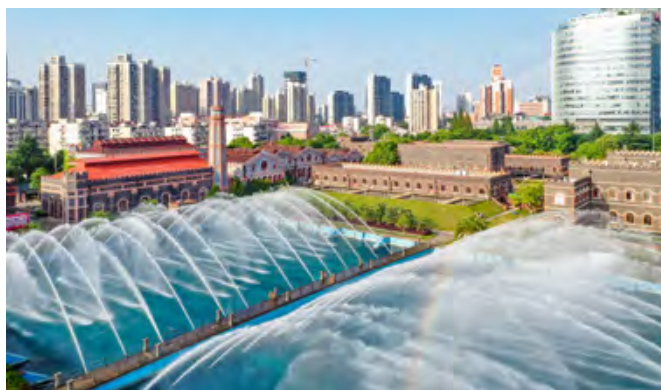
杨树浦水厂深度处理改造工程
