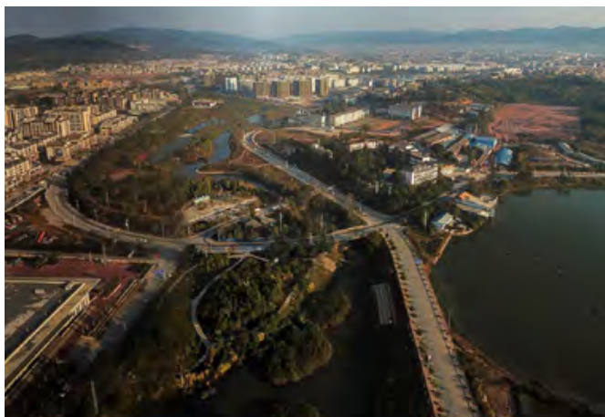
普洱市中心城区河道环境综合整治工程全景
