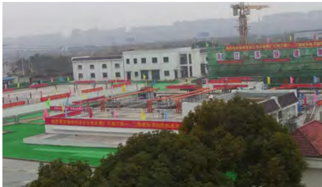
汤汪三期项目一二期提标改造工程通水
