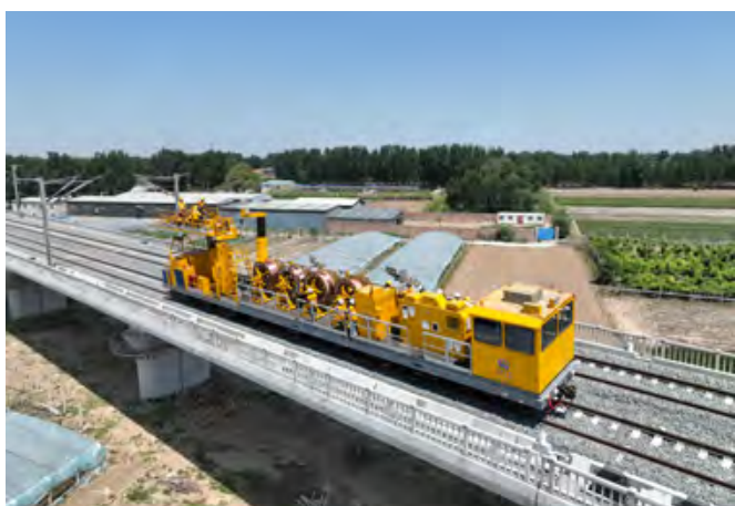
中铁自主研发的接触网恒张力架线车
