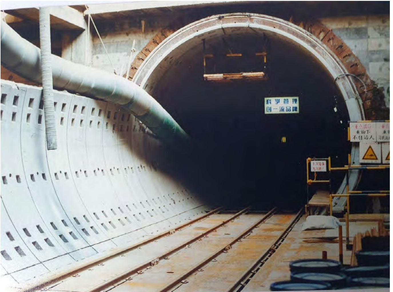
广州地铁建设现场
