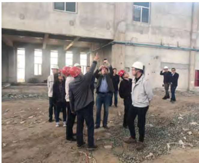
中德专家实地考察在建工程
