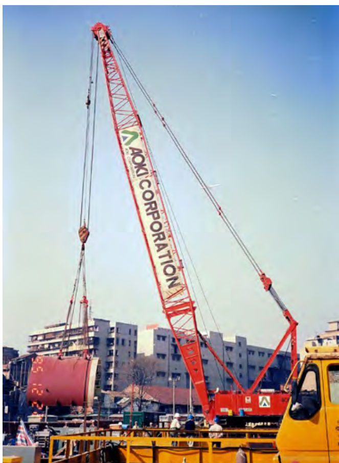
广州地铁一号线黄沙盾构机吊装
