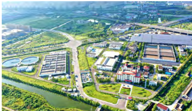
汤汪污水处理厂航拍图
