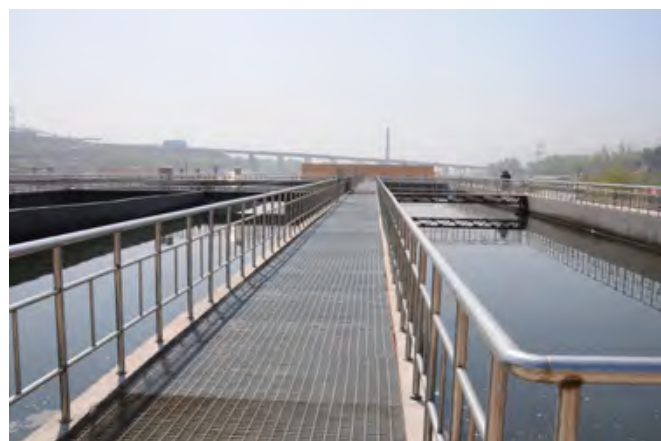
项目建设的生化池
