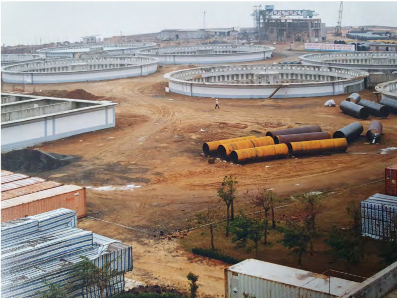
青岛污水处理厂的建设现场
