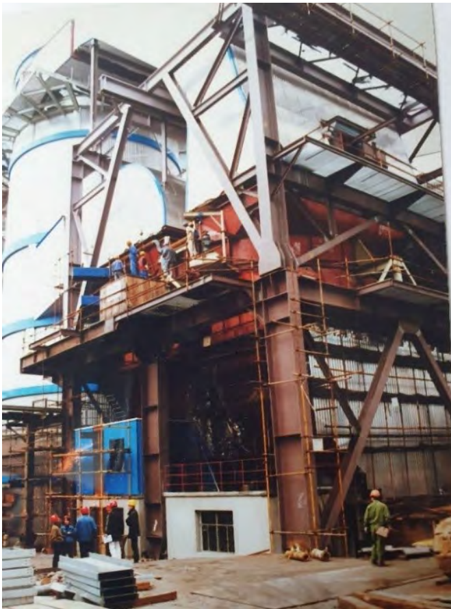
北京电厂脱硫装置建设及电厂改造
