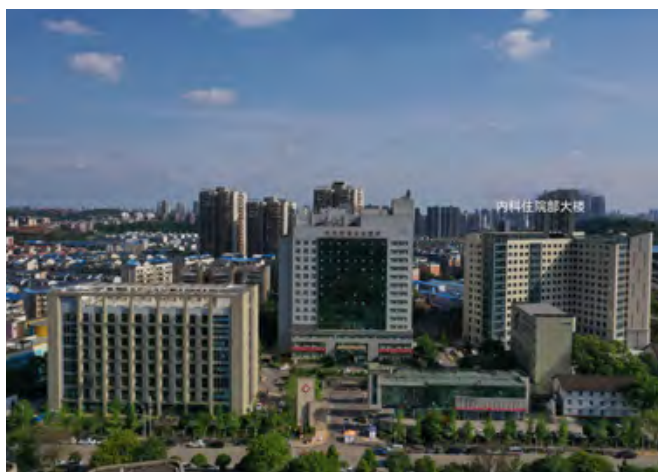
内科住院部大楼
