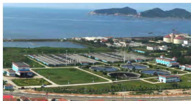
扩建工程全景图
