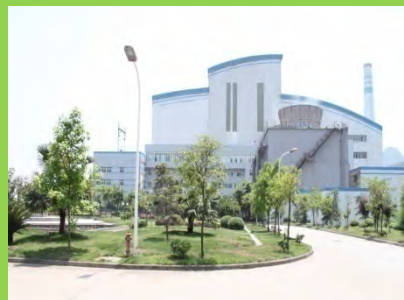
重庆同兴城市生活垃圾 焚烧发电项目
