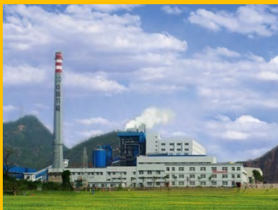
绍兴城市生活垃圾和污泥 焚烧发电项目
